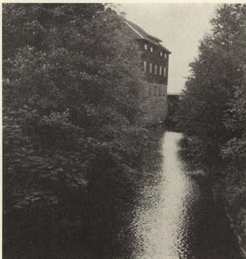
Än mellan sjöarna, som ju är nästan början till Tidan, var för kraftstationen nu rensad och rätad en bit.
